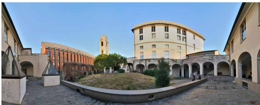
Panoramica del Dipartimento Architettura e Design di Genova
