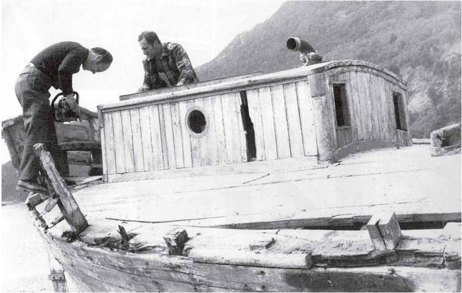
Particolare della tuga di poppa del leudo Angela Prima durante lo smantellamento del 1982. (Marta Lulleri, Proposta di restauro per il leudo Nuovo Aiuto di Dio , tesi di laurea magistrale in Design Navale e Nautico, Università di Genova, 2012-2013, p.106)
