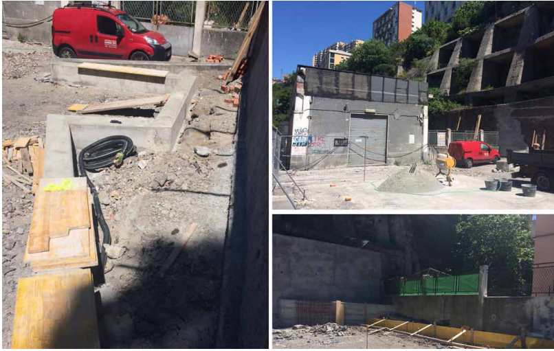
Mercato Aperto, via Bologna, Genova, Cantiere Spazi esterni, maggio 2017
