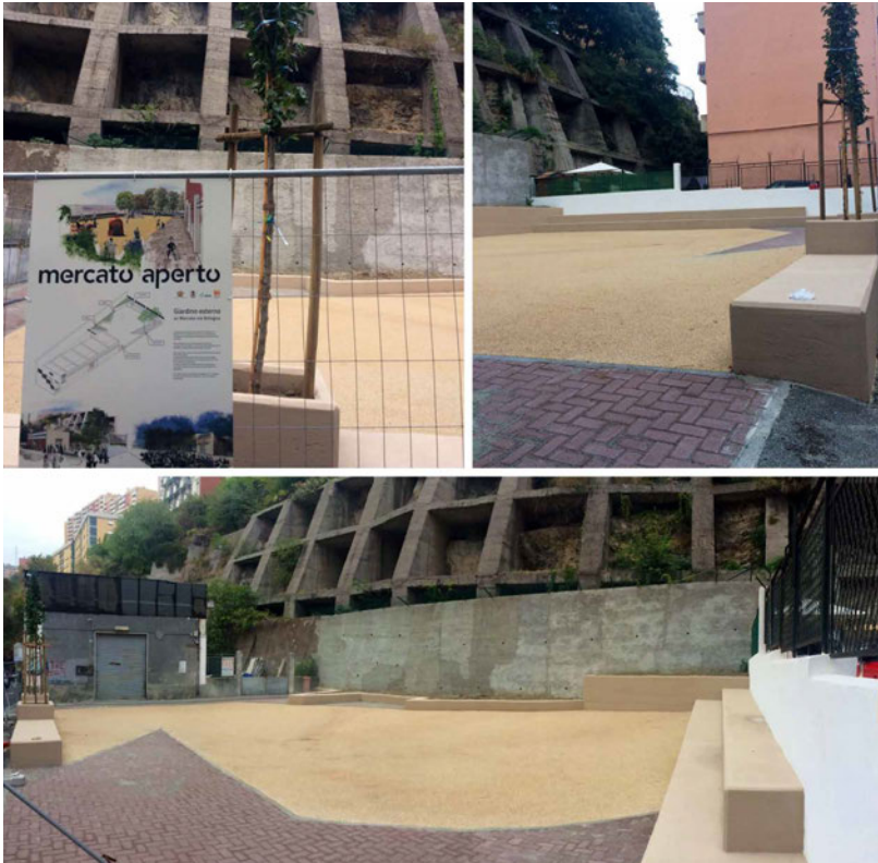
Mercato Aperto, via Bologna, Genova, Ultimazione Lavori Spazi esterni, settembre 2017
