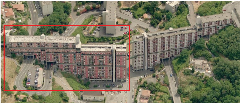
Figura 5.5 - Vista aerea dell’edificio. (Fonte: Google maps)
