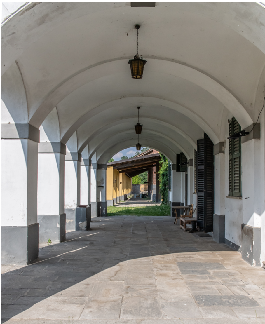
Fig. 4. Cascina Ri-Nascita, stato di fatto: il portico (foto di Tommy Della Frana).
