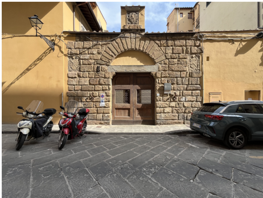
Fig. 2. Foto dell'ingresso all'Orbatello da via della Pergola.
