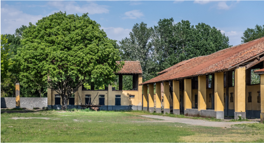
Fig. 3. Cascina Ri-Nascita, stato di fatto: la stalla grande e la stalla piccola (foto di Tommy Della Frana).
