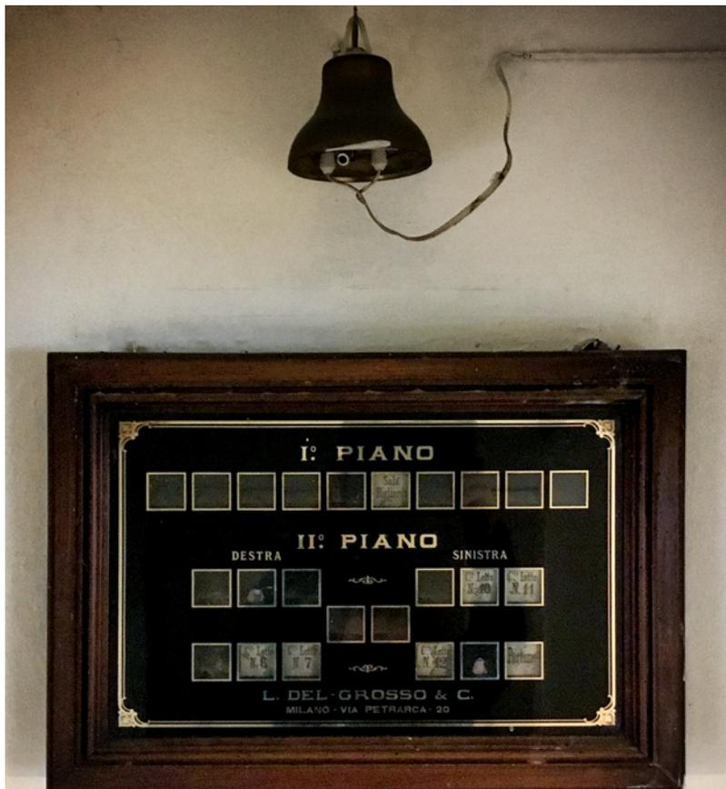
Fig. 25 – Palazzo Rocca, quadro elettrico del sistema per chiamare la servitù nell'appartamento della servitù al primo piano mezzanino realizzato dalla ditta L. Del Grosso.
