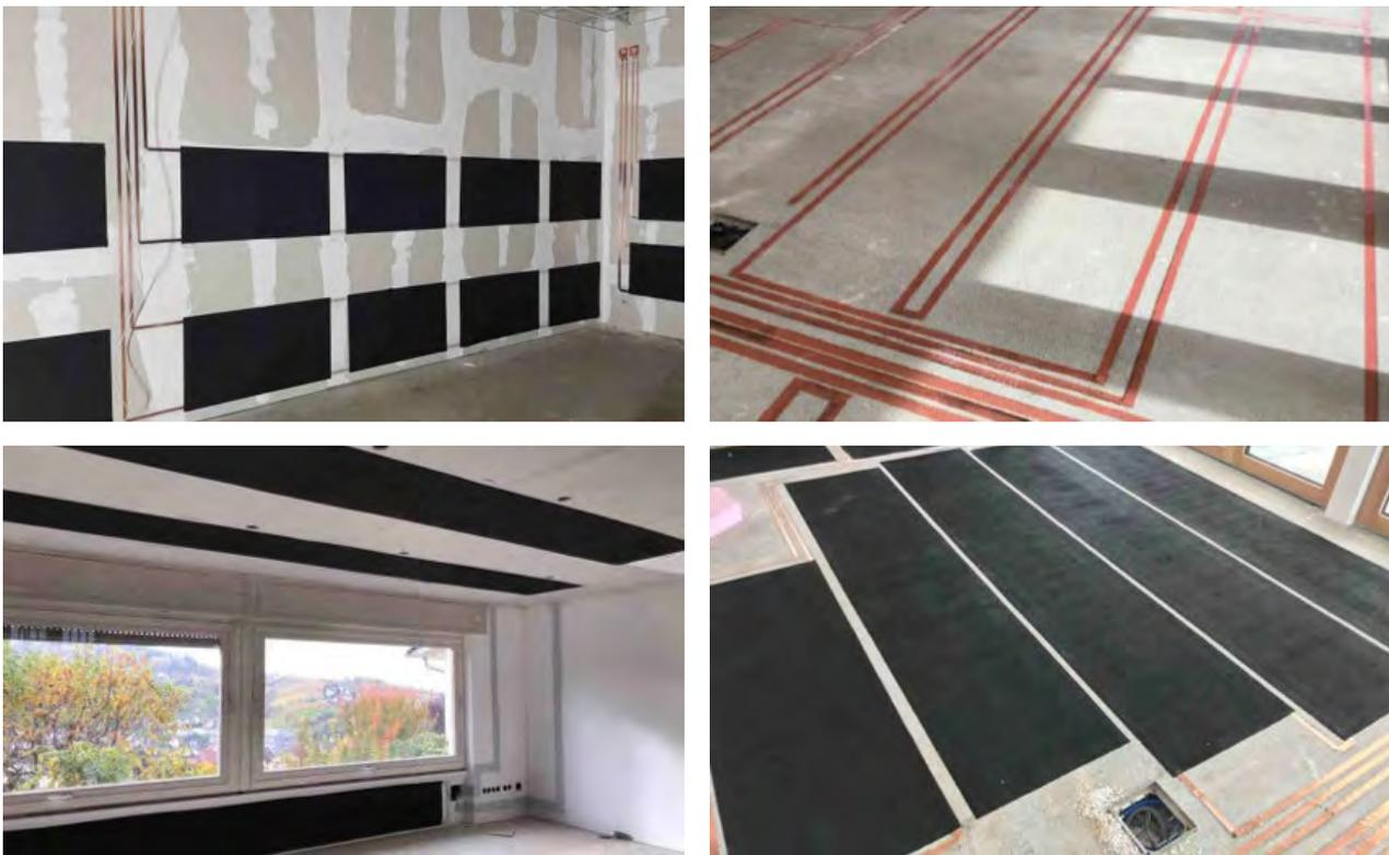
Fig. 4.8. Sistemi elettrotermici non metallici: a) installazione di elettrodi di rame; b) applicazione di vernice polimerica per parete radiante; c) applicazione per un soffitto radiante; d) applicazione per pavimento radiante. Fonte: Carbon4
