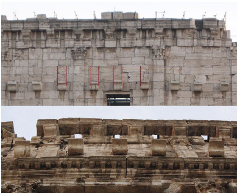
Fig. 68. Osservazioni delle mensole del Colosseo.
