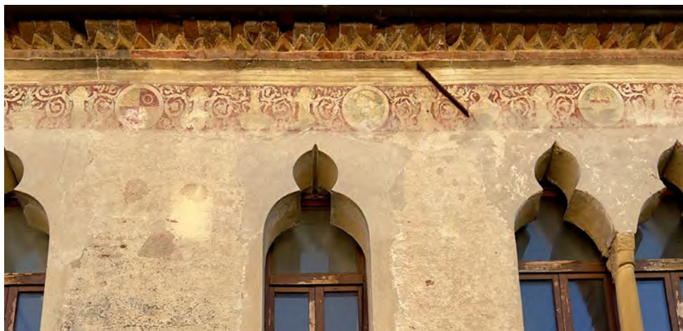
Fig. 4. Cittadella. Palazzo del Podestà, prospetto anteriore, particolare del fregio, 2024. Foto dell'A.
