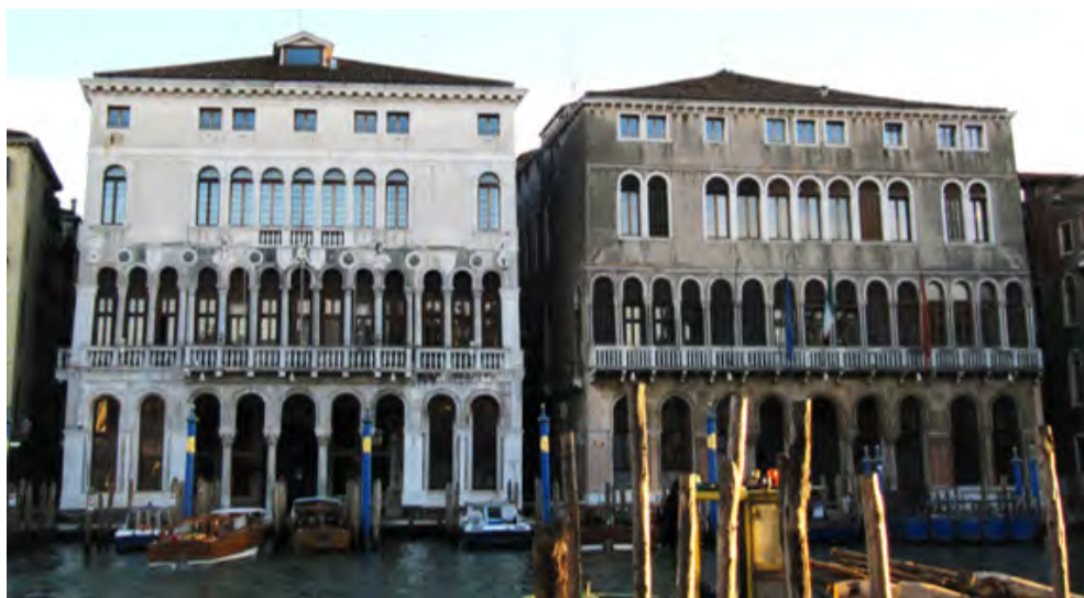
Fig. 2. Venezia, Ca' Loredan (a destra) e Ca' Farsetti (a sinistra), veduta dei prospetti sul Canal Grande. Da Wikimedia Commons.
