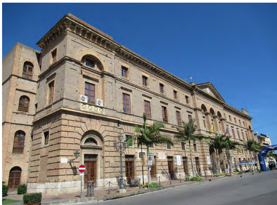
Fig. 3. Milazzo. Palazzo comunale, prospetto principale, 2025. Foto dell'A.
