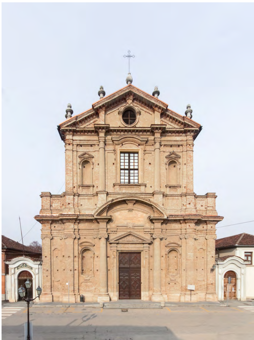
Fig. 5. Carmagnola. Facciata della chiesa di San Filippo Neri con a fianco due portali; uno costituisce l'ingresso al municipio. Foto dell'A.
