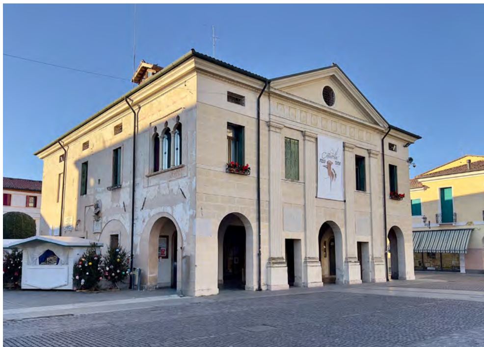
Fig. 5. Cittadella. Palazzo della Loggia, prospetto anteriore, 2024. Foto dell'A.
