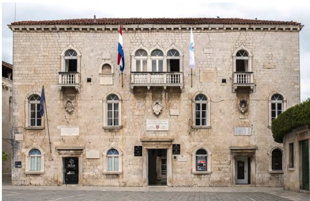
Fig. 8. Traù (Trogir). Palazzo comunale, inizio del XXI secolo.
