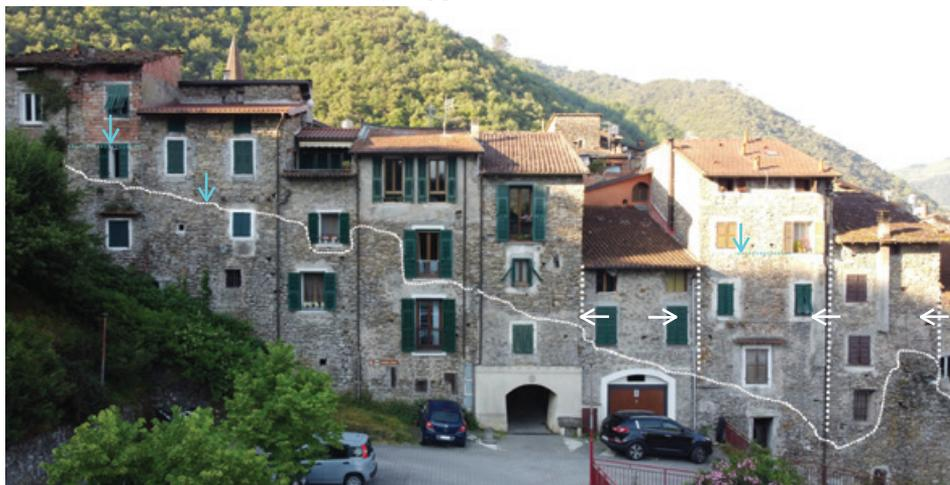
Individuazione del profilo delle mura, degli addossamenti e delle sopraelevazioni nell'edificio di Isolabona
