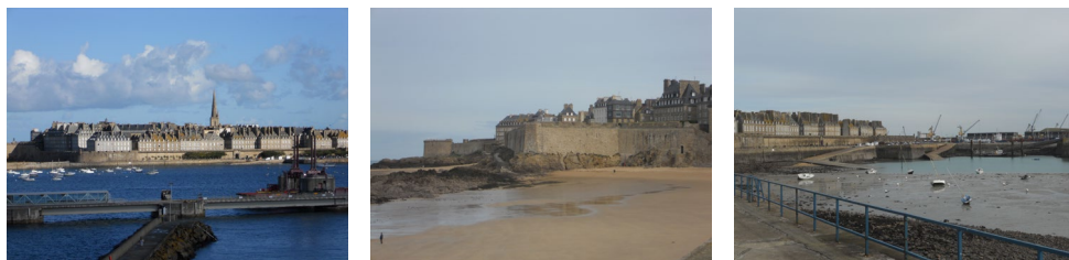
Photo n. 7 Les remparts de Saint-Malo et les digues
