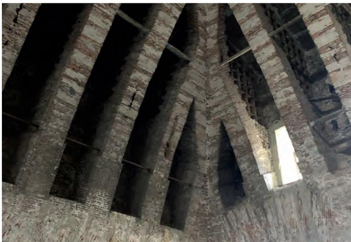
*Fig. 22 - Veduta della volta strutturale a costoloni in muratura del tetto sopra la Sala del Minor Consiglio*
