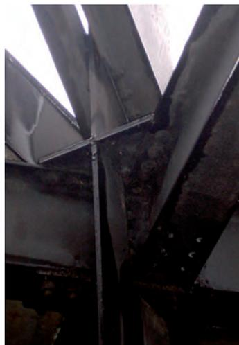
Fig. 160 - Particolare della soluzione di incastro tra gli elementi agli spigoli della cornice perimetrale
