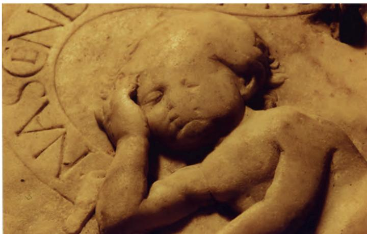
Fig. 262 - Fenomeno di degrado del marmo di una lastra tombale. Il fenomeno è definibile come erosione, secondo il Lessico delle Raccomandazioni UNI 11182
