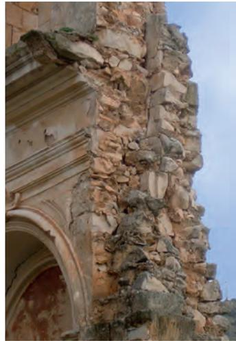
Fig. 190 - Particolare della sezione trasversale del muro perimetrale della chiesa
