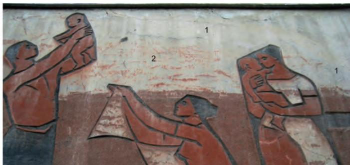
Fig. 131 - Particolare dei fenomeni di degrado del graffito di Janos Blaski: interruzioni di continuità del graffito dovute alla presenza di fessurazioni
