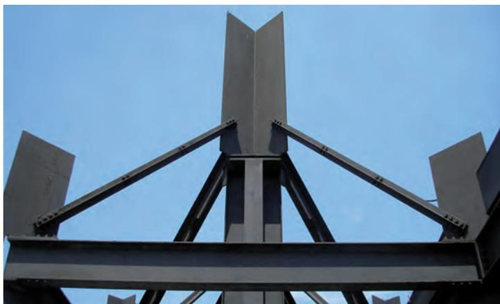
Fig. 156 - Particolare della soluzione di sommità della struttura portante in acciaio
