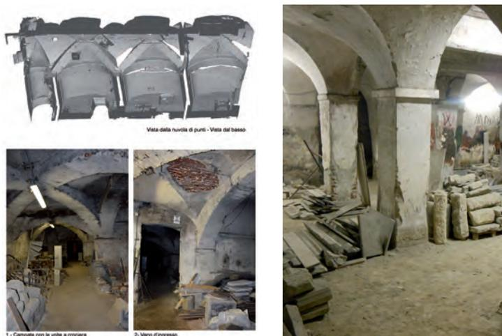
Fig. 32 - Rilievo digitale delle volte a costoloni del piano fondi della Villa del Principe Doria: elaborazione della nuvola di punti e viste degli ambienti del piano fondi
