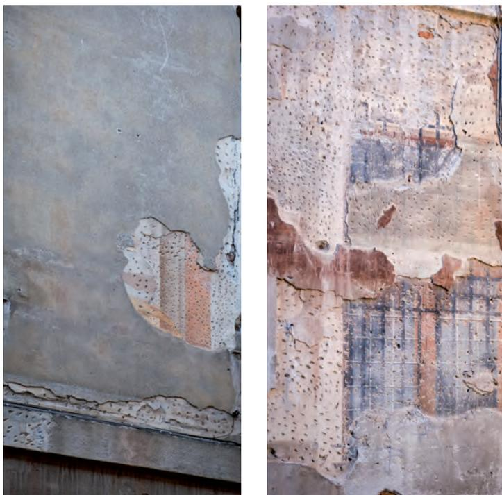
Fig. 200 - Particolari della facciata su via Roma. A sinistra, particolare di una mancanza nello strato di intonaco di epoca più recente. A destra, particolare della decorazione della facciata visibile attraverso le mancanze
