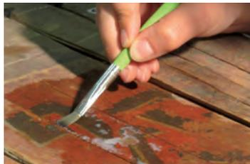
Fig. 50 - Applicazione di consolidante a pennello
