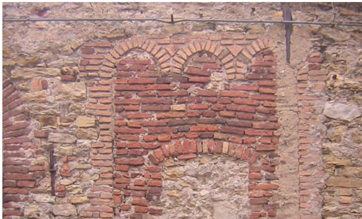
Fig. 15 - Stratificazione muraria con possibilità di datazione mensiocronologica
