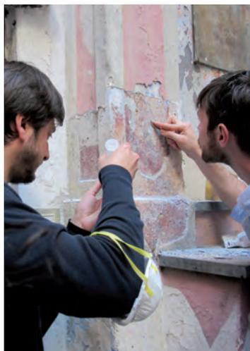
Fig. 59 - Descialbo con l'uso di bisturi e riadesione con iniezioni
