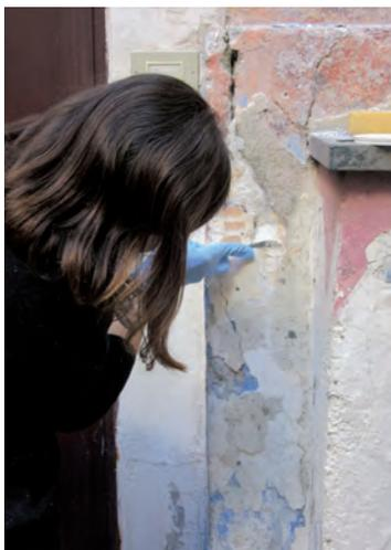
Fig. 58 - Stuccatura con malta compatibile
