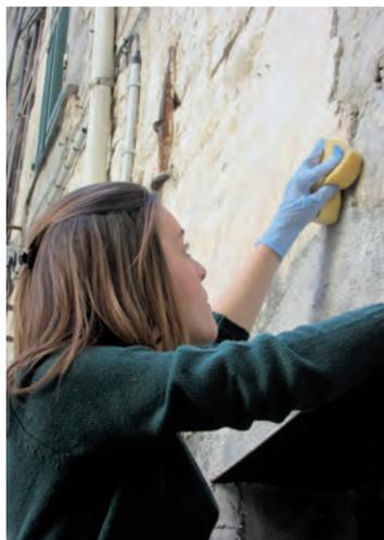
Fig. 57 - Trattamento bordi di una zona di mancanza dell'intonaco
