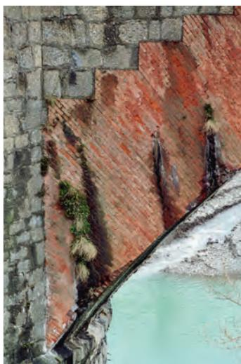
Fig. 226 - Esempi di fenomeni di alterazione e degrado: vegetazione infestante e incrostazioni carbonatiche
