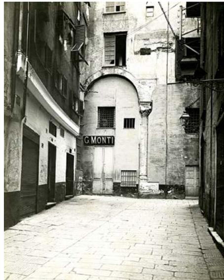
Fig. 55. La loggia nel 1920 circa. Centro DocSAI, Arch. Fotografico, s5830. Il tamponamento è arretrato rispetto al filo della facciata per dare più visibilità all'arco.
