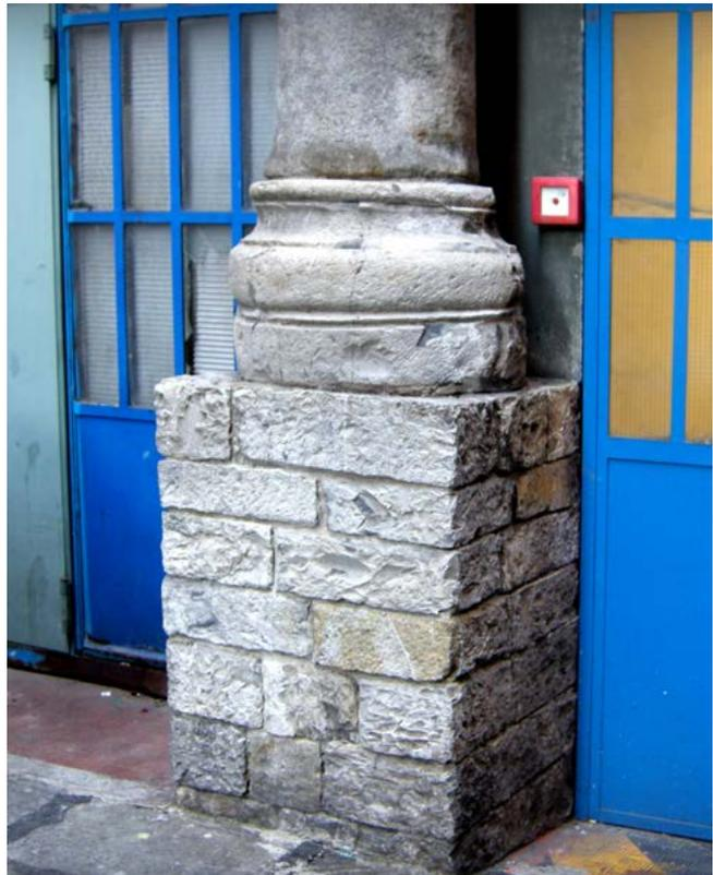
Fig. 36. Accesso alla loggia di Piazza Luxoro. La colonna centrale poggia su un alto basamento di conci squadrati (ricostruzione postbellica).
