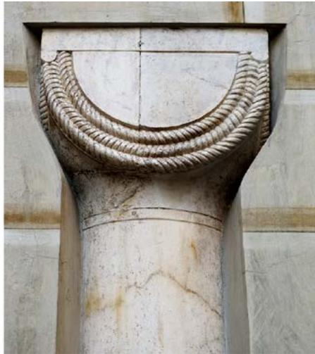
Fig. 34. Elemento quadrato di raccordo tra pilastro e mensola, loggia in Vico dei Notari 5r-7r. A destra, capitello cubico di matrice lombarda con festone cordonato, loggia in Piazza Cattaneo 80r.
