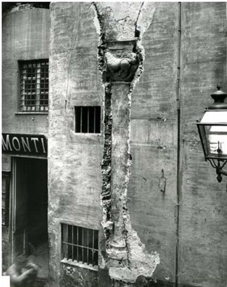
Fig. 54. La colonna di sostegno appena liberata dopo gli scrostamenti effettuati da Poggi. Centro DocSAI, Arch. Fotografico, s12980. La colonna si presenta arretrata rispetto all'edificio, all'interno dello scasso effettuato nella muratura, che verrà ripristinata lasciando in evidenza il manufatto medievale.
