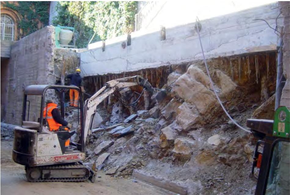
Figura 16.5 Arretramento del muro di sostegno dell'intercapedine.
