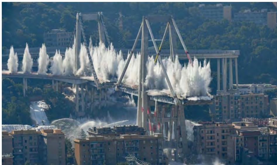
Figura 29.3 Genova, 28 giugno 2019, demolizione mediante esplosivo di ciò che restava del Viadotto Polcevera.
