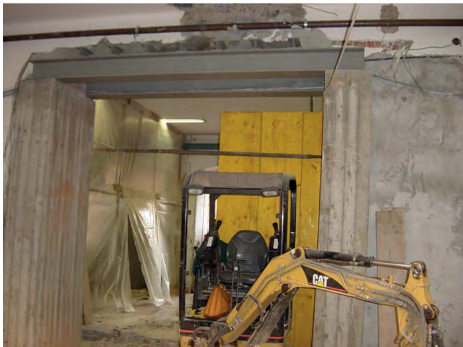
Figura 16.6 Apertura di varchi di collegamento nei maschi murari.
