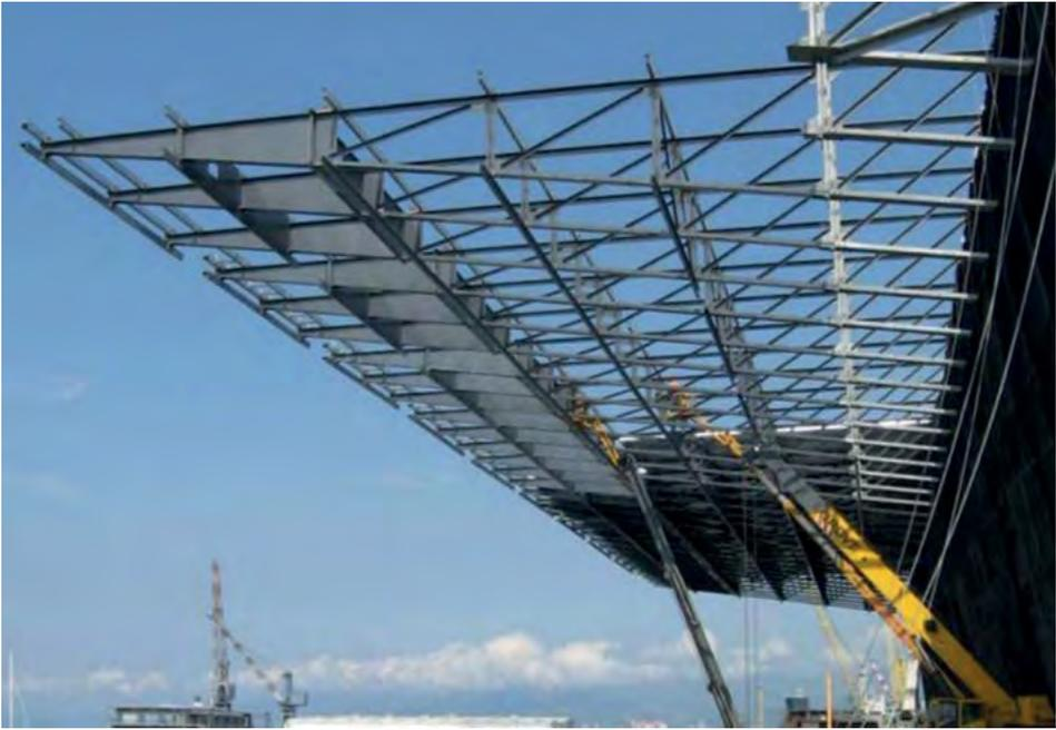
Figura 18.6 Parte a sbalzo della copertura del Padiglione B della Fiera di Genova.
