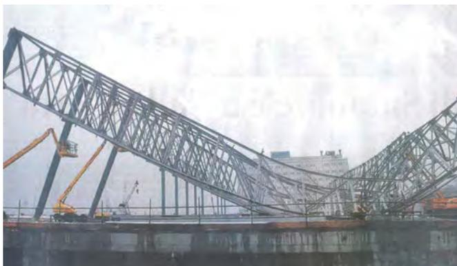
Figura 18.7 Crollo della copertura del Padiglione B della Fiera di Genova durante la costruzione.
