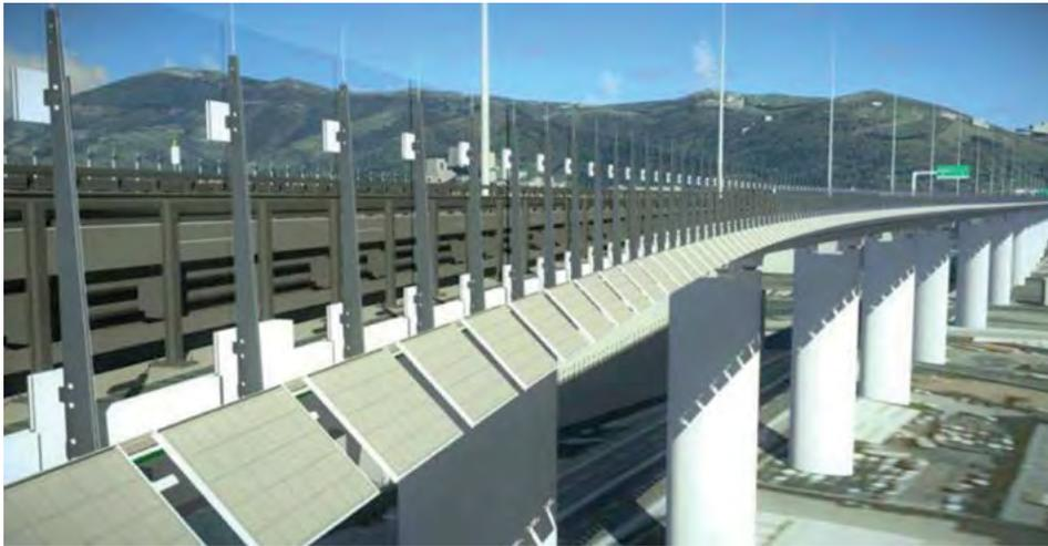
Figura 29.5 Barriere vetrate frangivento abbinata ai pannelli solari.
