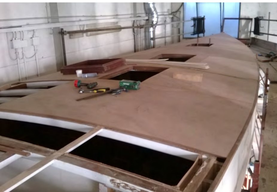
Restauro di Barbara , foto di cantiere, interventi sulla coperta (crediti fotografici: gentile concessione di Enrico Zaccagni).
