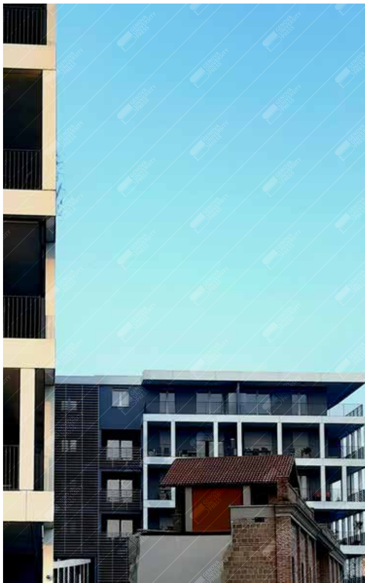
Fig. 61 Intensivo al Porto Fluviale (2014-17), area dell'ex-Consorzio Granario (portale di Tullio Passarelli, 1919, parzialmente conservato).
