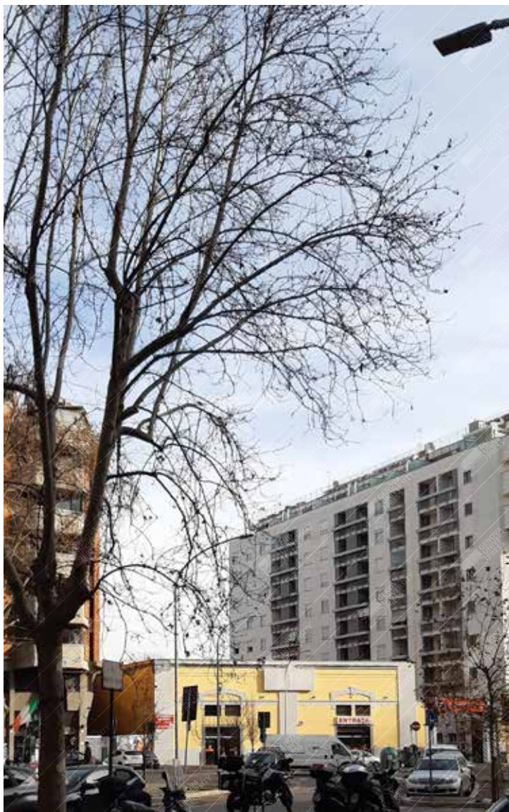
Fig. 58 Ultimo edificio ex-industriale conservato nell'area. A destra l'intensivo costruito dopo la demolizione del Pastificio Costa.
