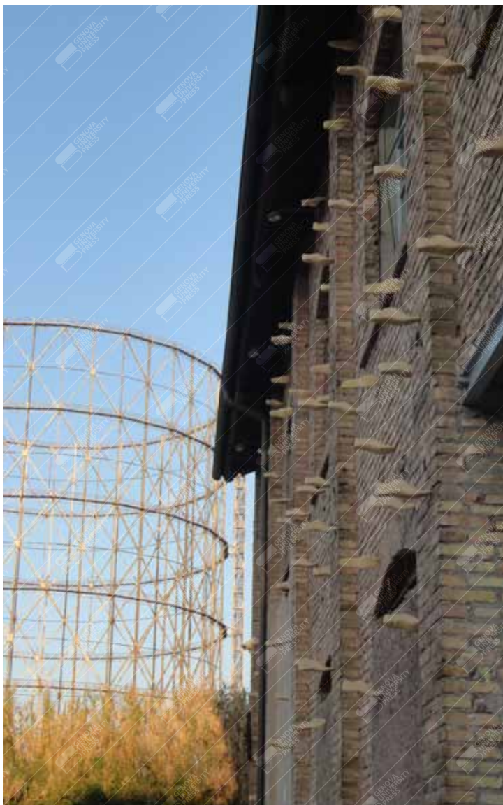
Fig. 32 Mimmo Paladino, fronte di ingresso del Teatro India (2004, allestimento dell' Edipo a Colono di Sofocle).
