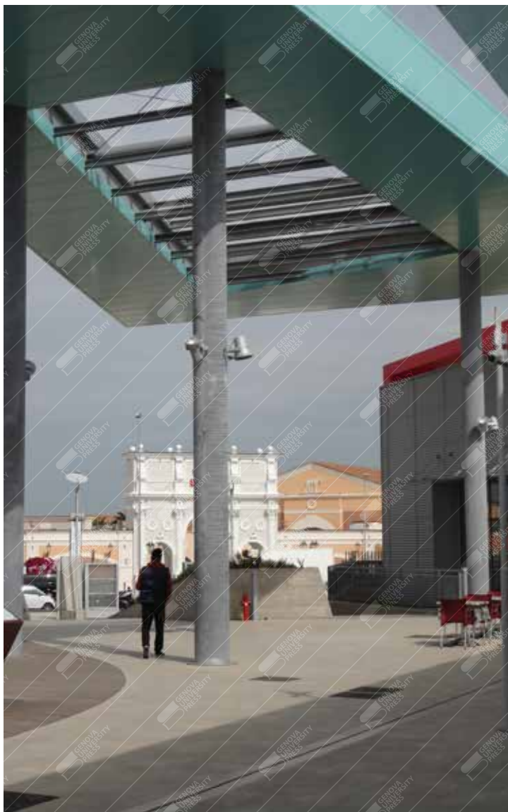
Fig. 48 Chapman & Taylor Shopping Village a Castel Romano, inaugurato nel 2012. Sullo sfondo l'ingresso di Designer Outlet (costruito nel decennio precedente).
