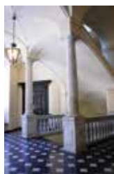
Palazzo Balbi Cattaneo, rampa di raccordo del rifacimento settecentesco.
